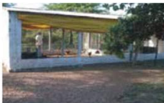
Fig. 12. Aviário de alvenaria com telhas de fibrocimento.
