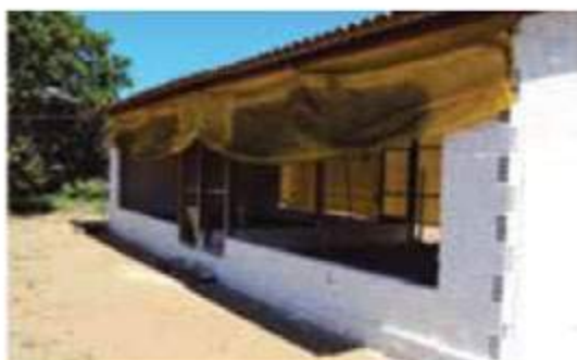
Fig. 11. Aviário de alvenaria com telhas de barro.
